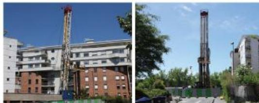
Cette opération nécessite la mise en œuvre d'une machine de service de type SMP12 (comme ci-dessus) et un ensemble d'équipements auxiliaires.
